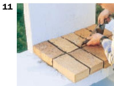
**11.** Jointoyer avec soin les briques. Ici, on utilise une poche en plastique percée d'un trou pour faire couler du mortier hydrofuge assez liquide entre les briques.
