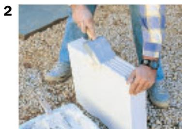
1. Les jambages sont fixés à la colle à béton cellulaire sur une dalle de béton servant d'assise
