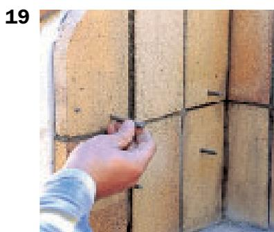
**19.** Une fois le mortier sec, percer des trous dans les côtés pour y enfiler des morceaux de tige métallique de 8 mm de diamètre, qui constitueront les taquets de la grille.
