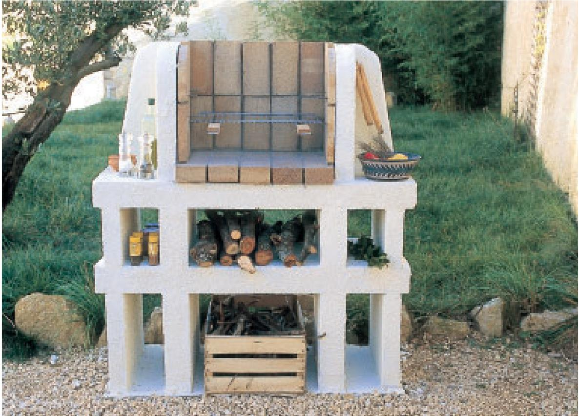
**L**e béton cellulaire est un matériau de construction qui présente des qualités spécifiques : la légèreté, un bon coefficient d'isolation thermique, une bonne résistance à la chaleur et une grande facilité de travail. Les blocs de béton cellulaire existent en différentes dimensions pour la réalisation de murs ou de cloisons. Ils conviennent parfaitement à la construction de barbecues et donnent une certaine liberté de forme.
