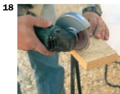
**18.** Découper la brique avec une meuleuse équipée d'un disque à tronçonner.
