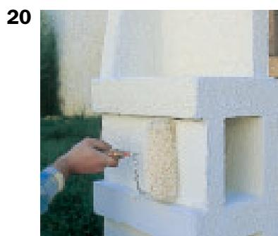
**20.** Protéger et décorer le béton cellulaire par un crépi pour façade.
